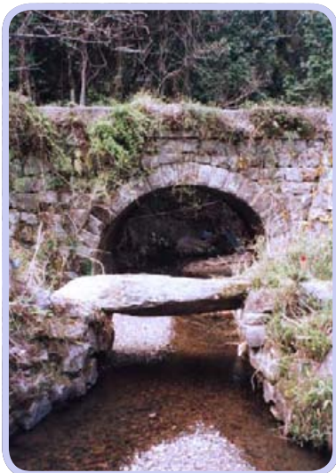
吐合橋・・・白杵市大字武山／架設年：昭和6年(1931)10月／橋長：7.9 m 橋幅：4.2 m／拱矢：2.0 m／径間：3.9 m／環厚：46cm／単一アーチ
