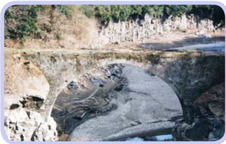
近戸橋・・・臼杵市大字乙見／架設年：明治 26 年 (1893) 6 月／橋長：26.7 m 橋幅：5.4 m／拱矢：11.1 m／径間：23.7 m／環厚：60～80cm／単一アーチ
