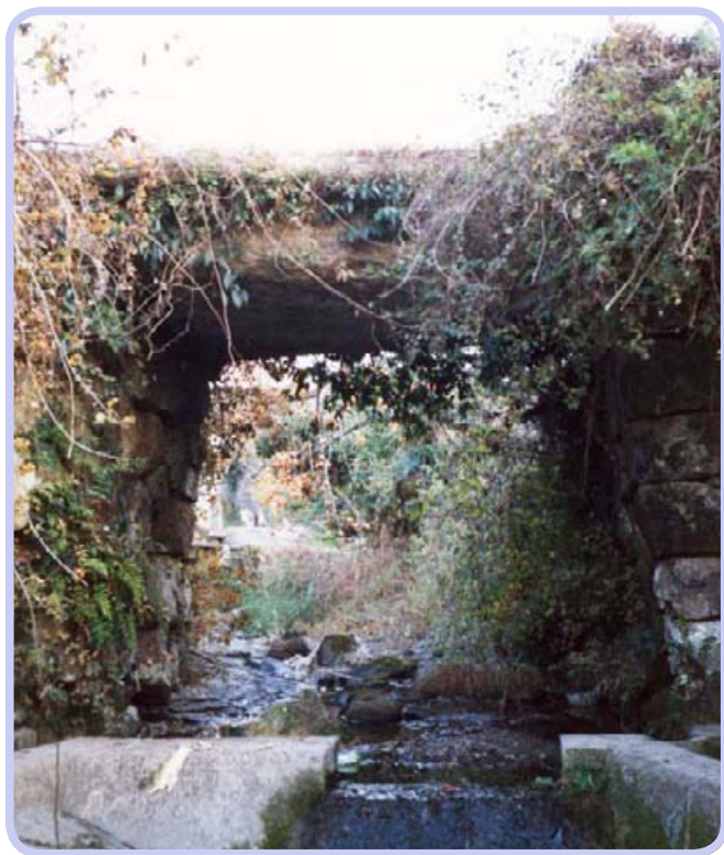
乙見橋・・・・・・・・臼杵市大字乙見／架設年：江戸後期（1780～1868）と推定 橋長：4.5 m／橋幅：2.0 m／単径間桁橋
