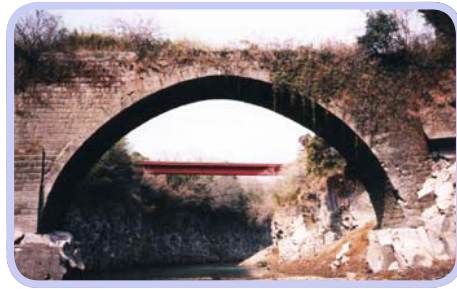
近戸橋・・・臼杵市大字乙見／架設年：明治 26 年 (1893) 6 月／橋長：26.7 m 橋幅：5.4 m／拱矢：11.1 m／径間：23.7 m／環厚：60～80cm／単一アーチ
