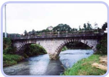
久保橋 ・ ・ ・ ・ ・ 臼杵市大字吉小野 久保／架設年：大正 14 年 (1925)4 月 橋長：15.4 m／橋幅：4.4 m／径間：6.3 m／環厚：40cm／2 連アーチ
