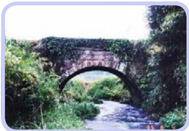
川原橋・・・臼杵市大字久木小野川原／架設年：昭和 18 年 (1943)／橋長：7.4 m 橋幅：3.8 m／拱矢：2.25 と 2.4 m／径間：5.5 m／環厚：35cm／単一アーチ
