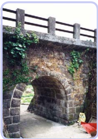
荒田家野橋・・・臼杵市大字家野／架設年：大正 12 年 (1923)／橋長：6.1 m 橋幅：3.6 m／拱矢：1.2 m／径間：2.4 m／環厚：40cm／単一アーチ
