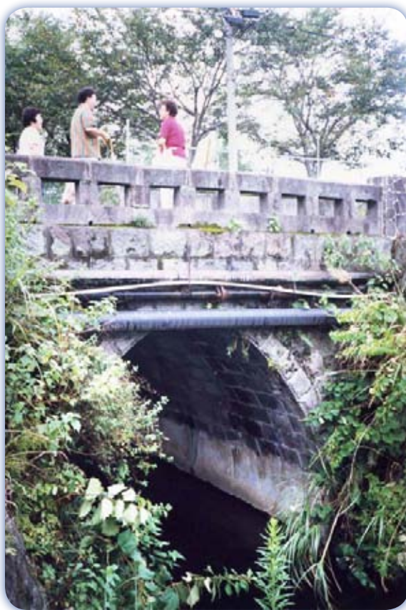
板地橋・・・・・・・・・・別府市南莊園町／架設年：昭和 22(1947) 年頃と推定 橋長：10.0 m／橋幅：7.0 m／単一アーチ
