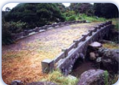
南立石公園橋・・・・・・・・・・別府市南立石／架設年：昭和 57(1982) 年 橋長：13.5 m／橋幅：4.7 m／拱矢：0.75 m／径間：2.8 m／2 連アーチ
