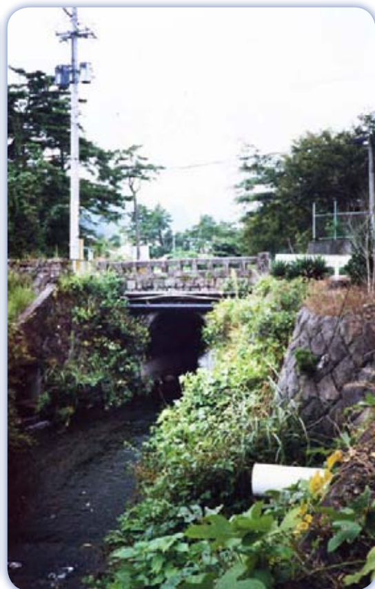
板地橋・・・・・・・・・・別府市南莊園町／架設年：昭和 22(1947) 年頃と推定 橋長：10.0 m／橋幅：7.0 m／単一アーチ
