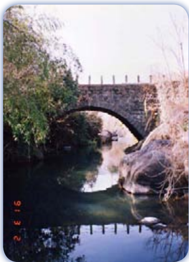
内成橋・・・・・・・・・・別府市大字内成／架設年：昭和8(1933)年3月 橋長：11.4 m／橋幅：4.1 m／径間：8.3 m／環厚：52 m／単一アーチ
