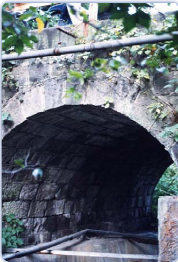
中組橋 ..... 別府市鉄輪 / 架設年：不明 橋長：7.0 m / 橋幅：7.5 m / 単一アーチ
