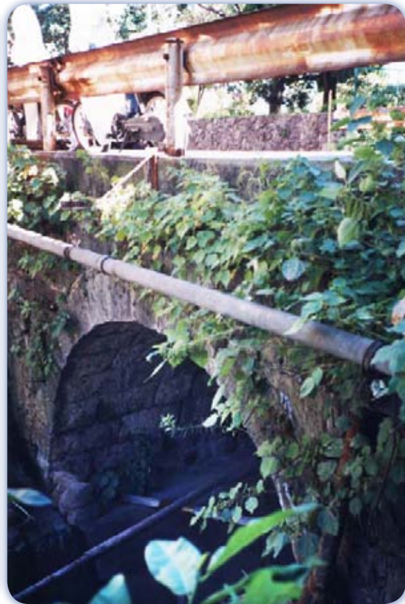
中組橋 ..... 別府市鉄輪 / 架設年：不明 橋長：7.0 m / 橋幅：7.5 m / 単一アーチ
