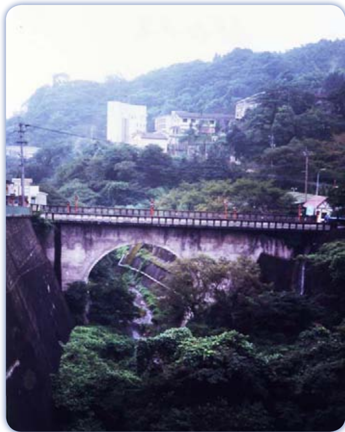
観海寺橋・・・・・・・・・・別府市観海寺／架設年：大正 11(1922) 年 10 月 橋長：35.5 m／橋幅：5.5 m／単一アーチ
