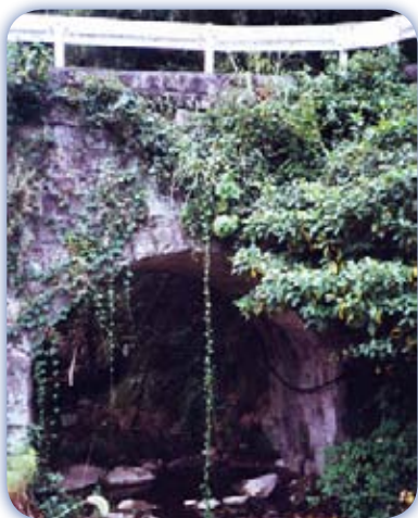
城の内橋・・・・・・・・・・別府市内童／架設年：昭和10(1935)年3月 橋長：7.0m／橋幅：2.4m／径間：4.5m／環厚：35cm／単一アーチ
