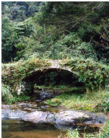
七所宮神橋・・・中津市本耶馬溪町 東屋形 前鶴／架設年：昭和 13(1938) 年 12 月 橋長：6.0 m／橋幅：2.7 m／拱矢：1.0 m／径間：5.4 m／単一アーチ
