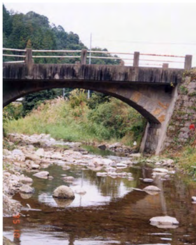
小川内橋・・・中津市本耶馬溪町 東屋形 石場／架設年：大正 14(1925) 年 5 月 橋幅：2.7 m／拱矢：1.5 m／径間：6.6 m／環厚：45c m／単一アーチ
