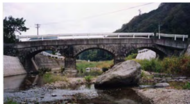
堤橋・・・中津市本耶馬溪町 東屋形 堤／架設年：大正末期（1922～1926）と推定 橋長：21.0 m／橋幅：2.8 m／拱矢：1.0 m／径間：5.0 m／環厚：40cm／3 連アーチ
