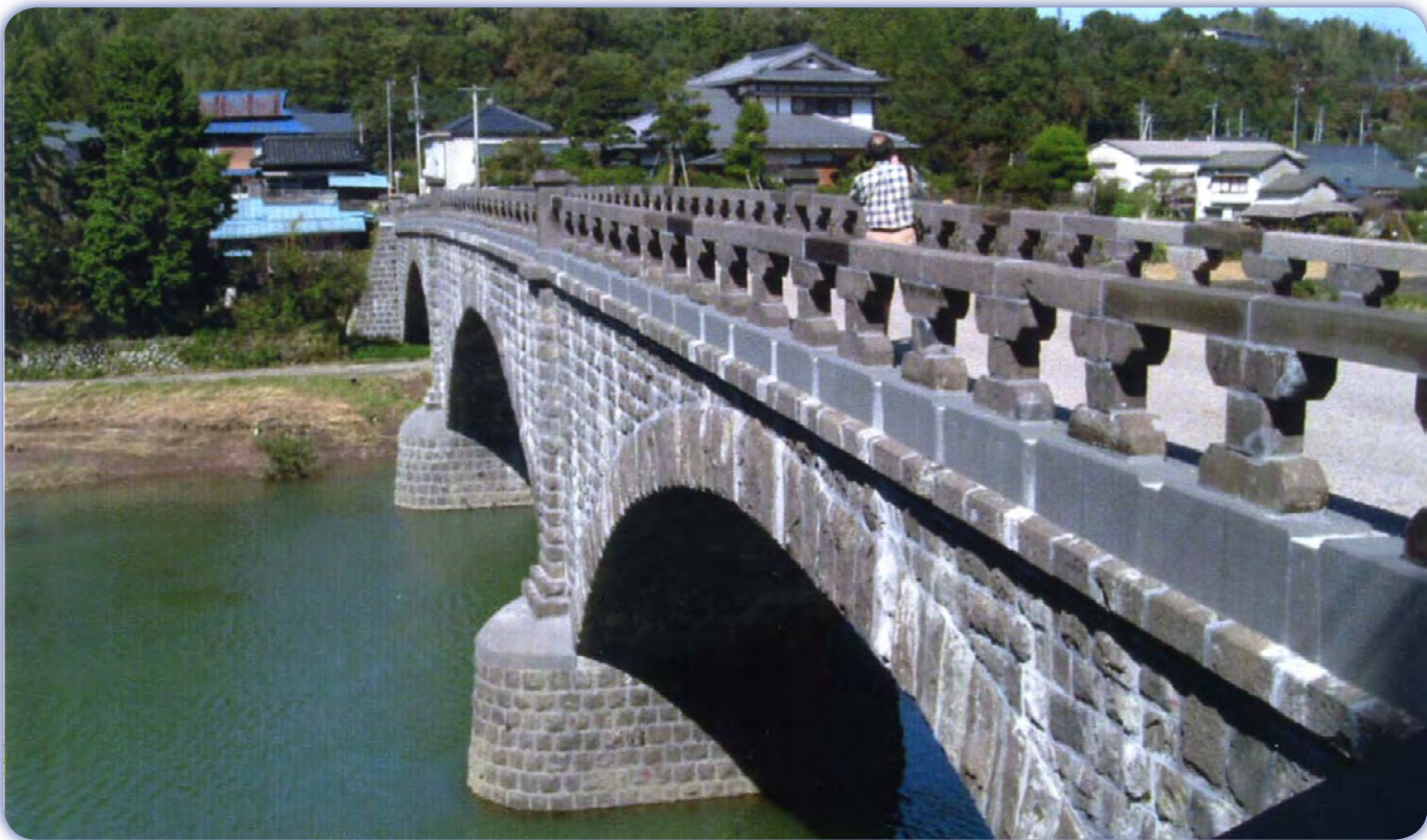
羅漢寺橋・・・中津市本耶馬溪町 曾木／架設年：大正 9 年 (1920)10 月／橋長：89.0 m 橋幅：4.5 m／拱矢：4.6 m／径間：26.2 m／環厚：90cm／3 連アーチ／県指定有形文化財
