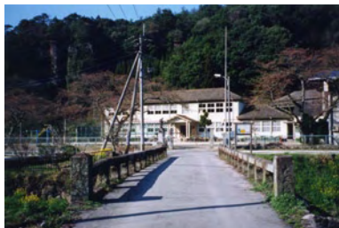
大正橋 ・ ・ ・ ・ ・ 中津市本耶馬溪町 東屋形 前鶴／架設年：大正 3 年(1914) 橋長：27.0 m／橋幅：3.8 m／拱矢：1.5 m／径間：6.0 m／環厚：45c m／2 連アーチ
