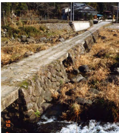
神迎橋 ・ ・ ・ ・ ・ 中津市本耶馬溪町 今行 粉 / 架設年：大正 14(1925) 年 6 月 橋長：38.6 m / 橋幅：2.1 m / 5 径間桁橋
