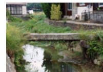
両岸から斜めに突き出した石の上に桁石2本を置いた勿ね橋、地藏尊雀橋
