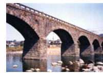
県指定有形文化財の耶馬溪橋
