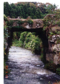
桁石を並べて架けた橋本橋
