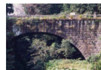
明治型工法の阿南橋
