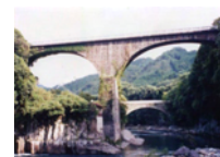
径間長全国一の轟橋
