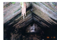
合掌型に桁石を築いた草深野の石橋
