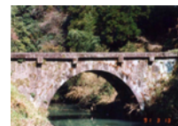
石造アーチ橋（オダニの車橋）
