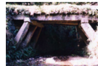
斜めに突き出した方杖石で支えたとくしん橋
