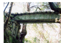
二本の桁石の上に板石を並べた久地橋
