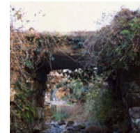
一枚石の桁石橋、乙見橋
