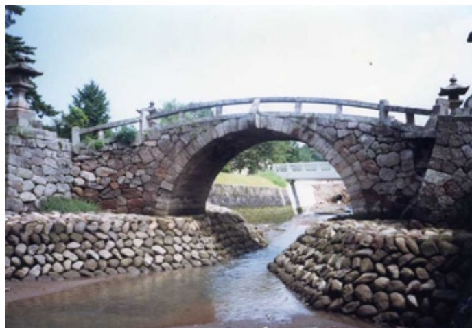
改修後の潮観橋（基礎固めに自然石の丸石が使われている）
