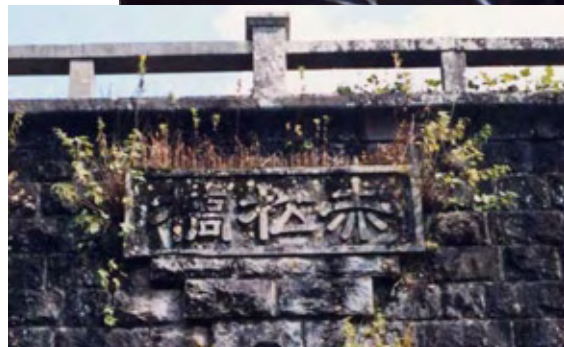
阿南橋（上）と赤松橋（下）の橋名板
