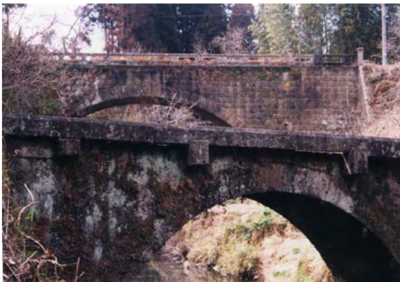
独特のせり出し桁を持つオダニの車橋（手前）と阿南橋（奥）
